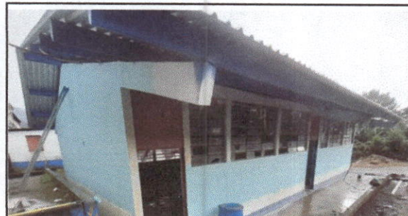
FOTO 4: Sustitución de canal de metal
