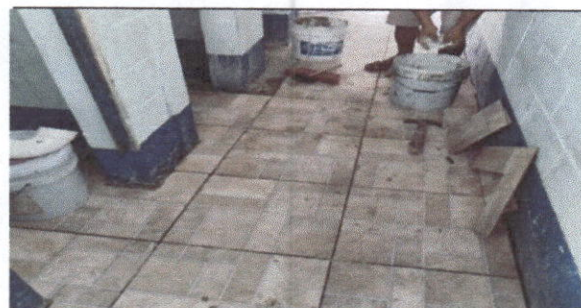
FOTO 6: Reparación de piso cerámico
