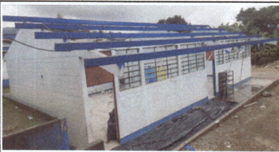
FOTO 3: Mantenimiento a estructura de soporte de metal
